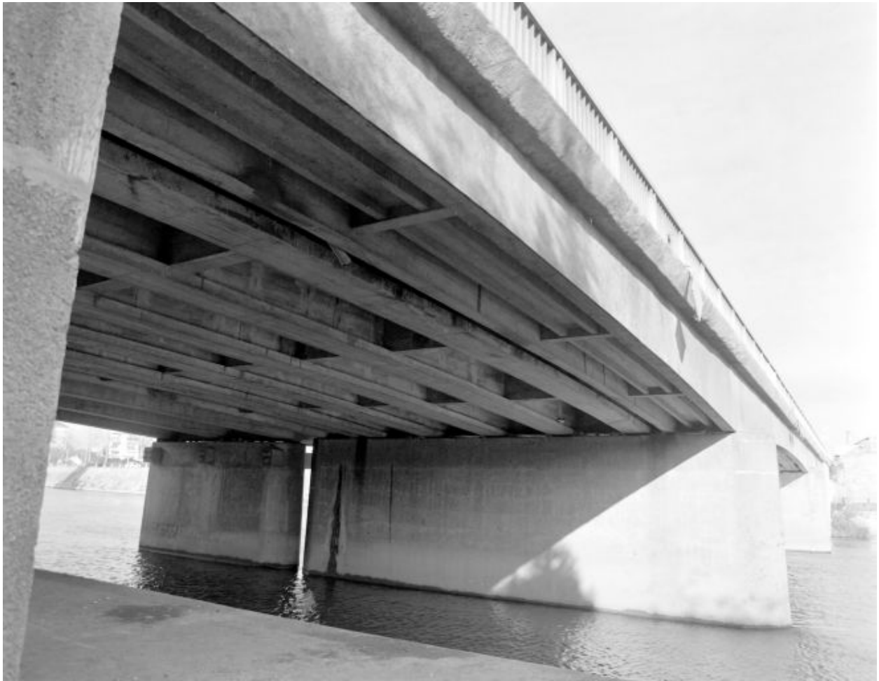
Vue de la structure du pont, sous le tablier, depuis la rive droite.
