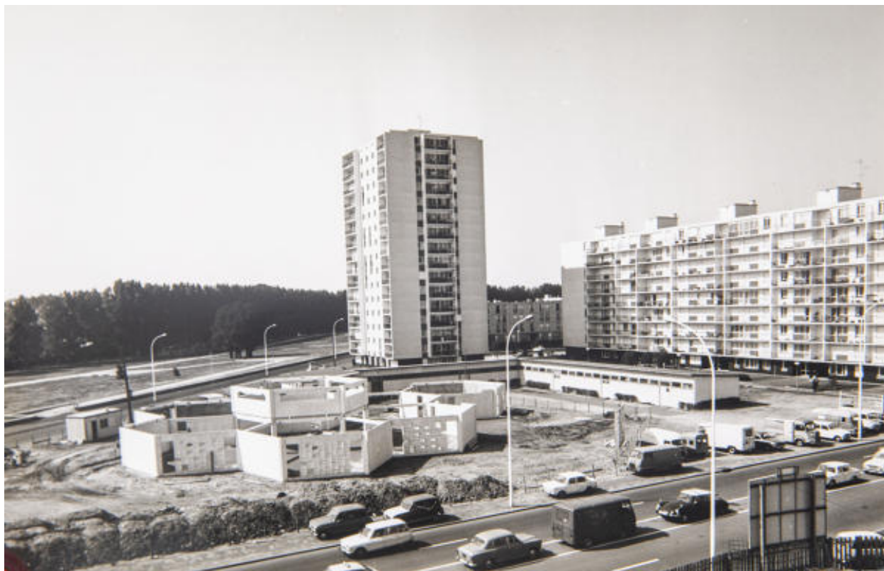
Photographie du chantier de l'église Saint-Bernard-des-Sablons.
