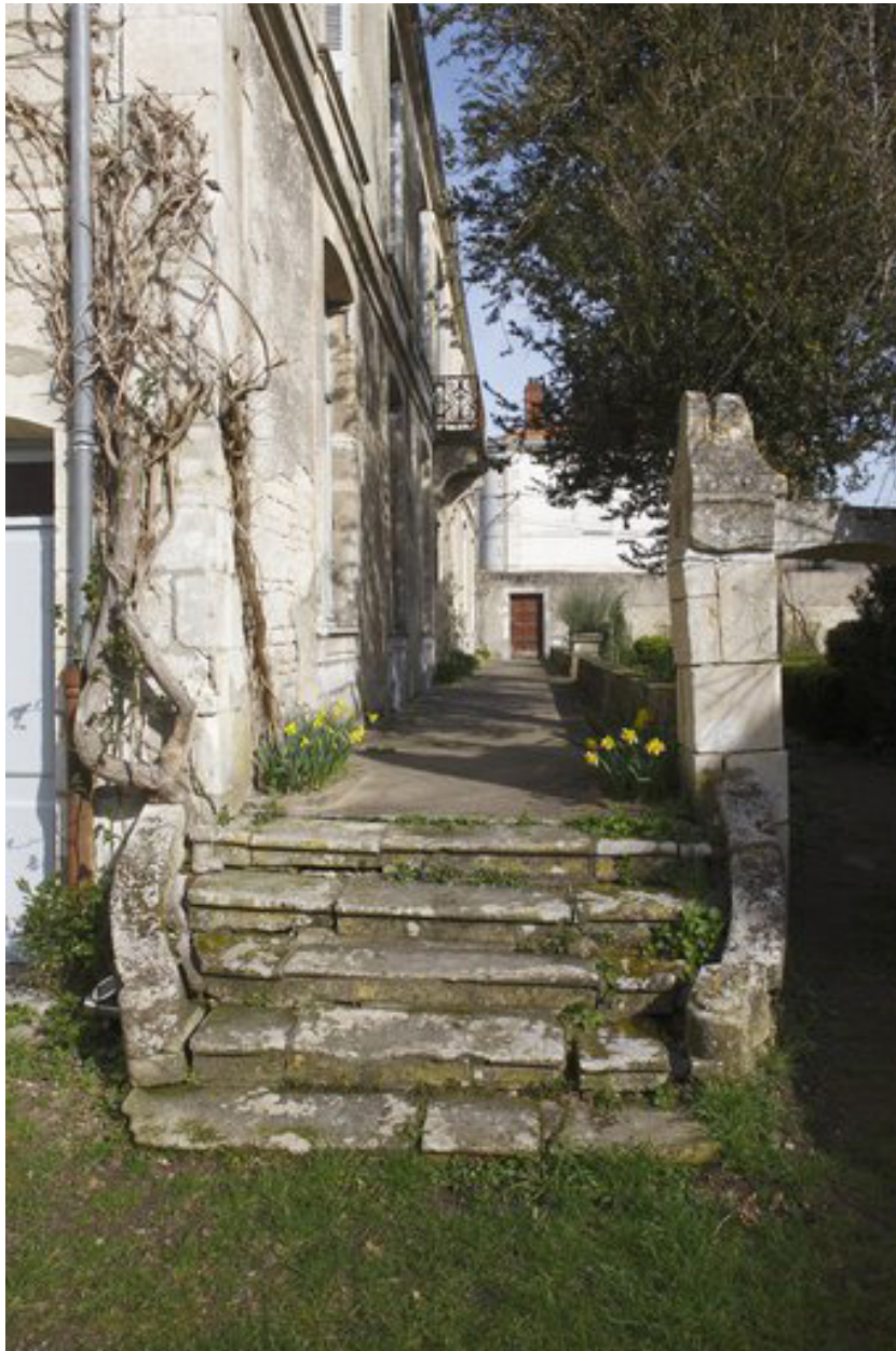
Vue prise de la cour, montrant la terrasse devant la façade est.
