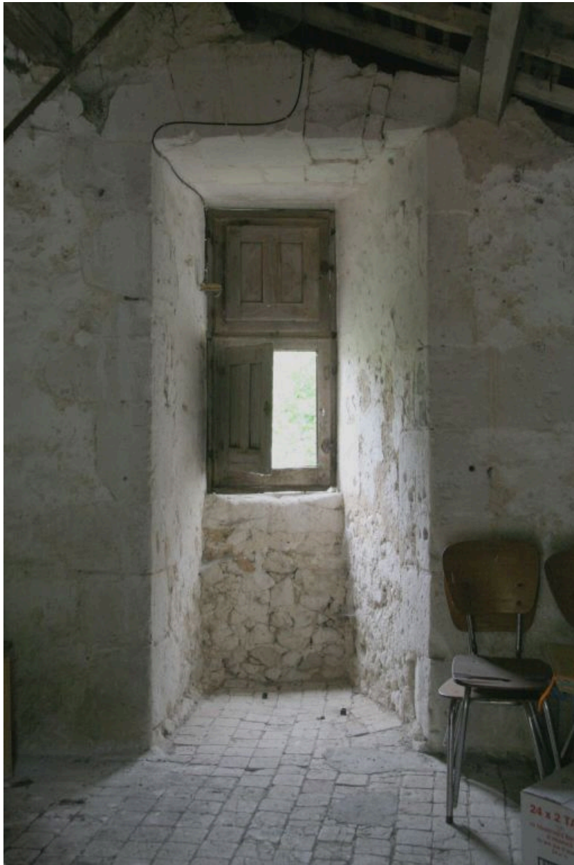
Tourelle, 1er étage, demi-croisée : menuiserie.
