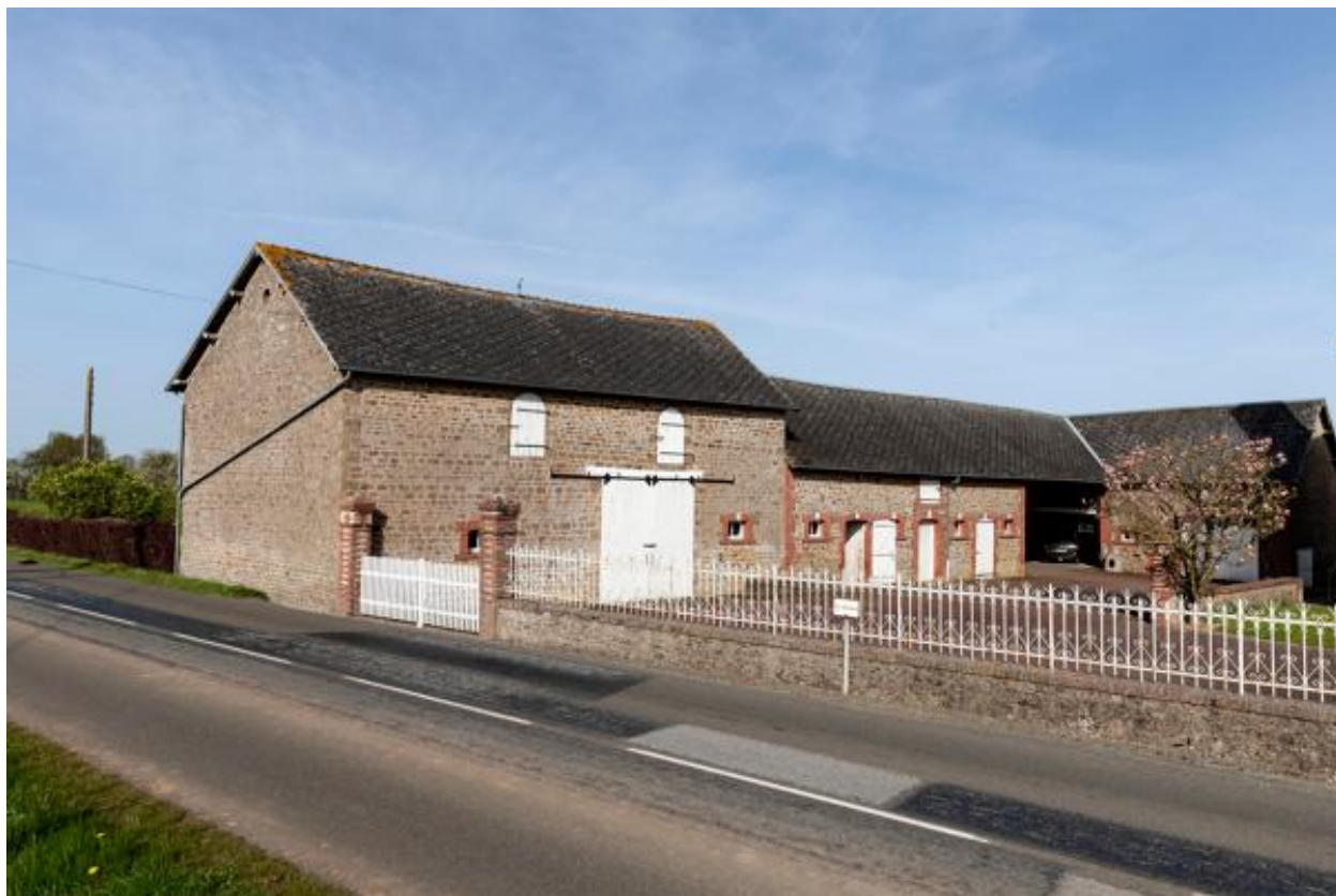
Ferme du Fresne : remise, étable, fenil, grange.
