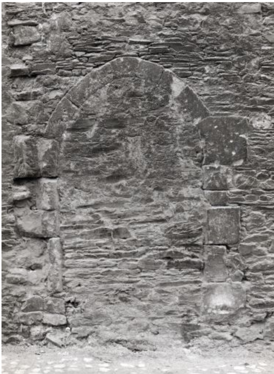
Mur de clôture, rue de la Chartre : porte murée.
