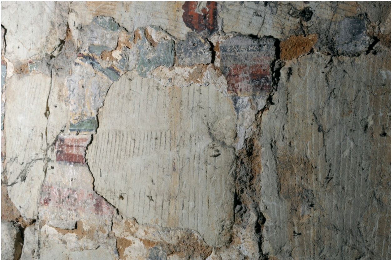
Comble, mur nord. Détail des vestiges de la peinture murale médiévale (2).
