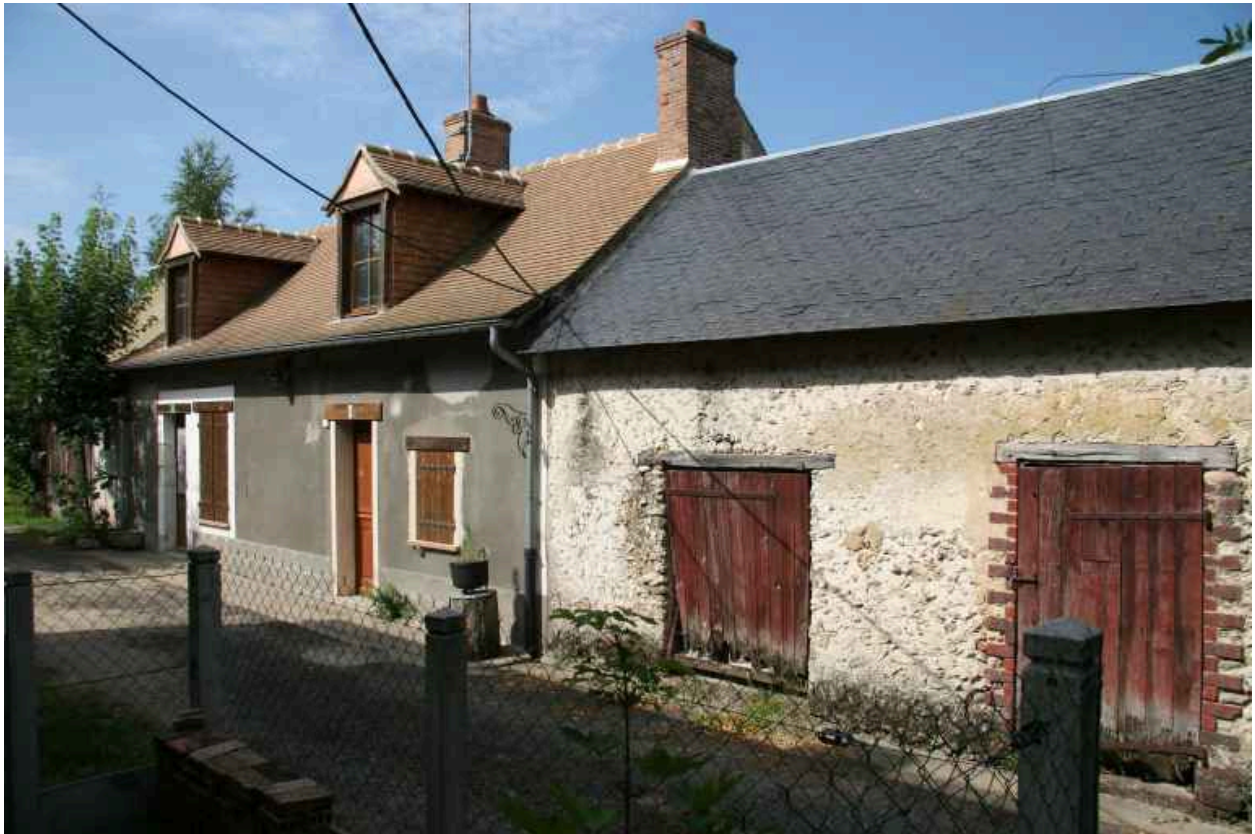
Rue des Lilas, rive ouest : petite maison très remaniée et dépendances.
