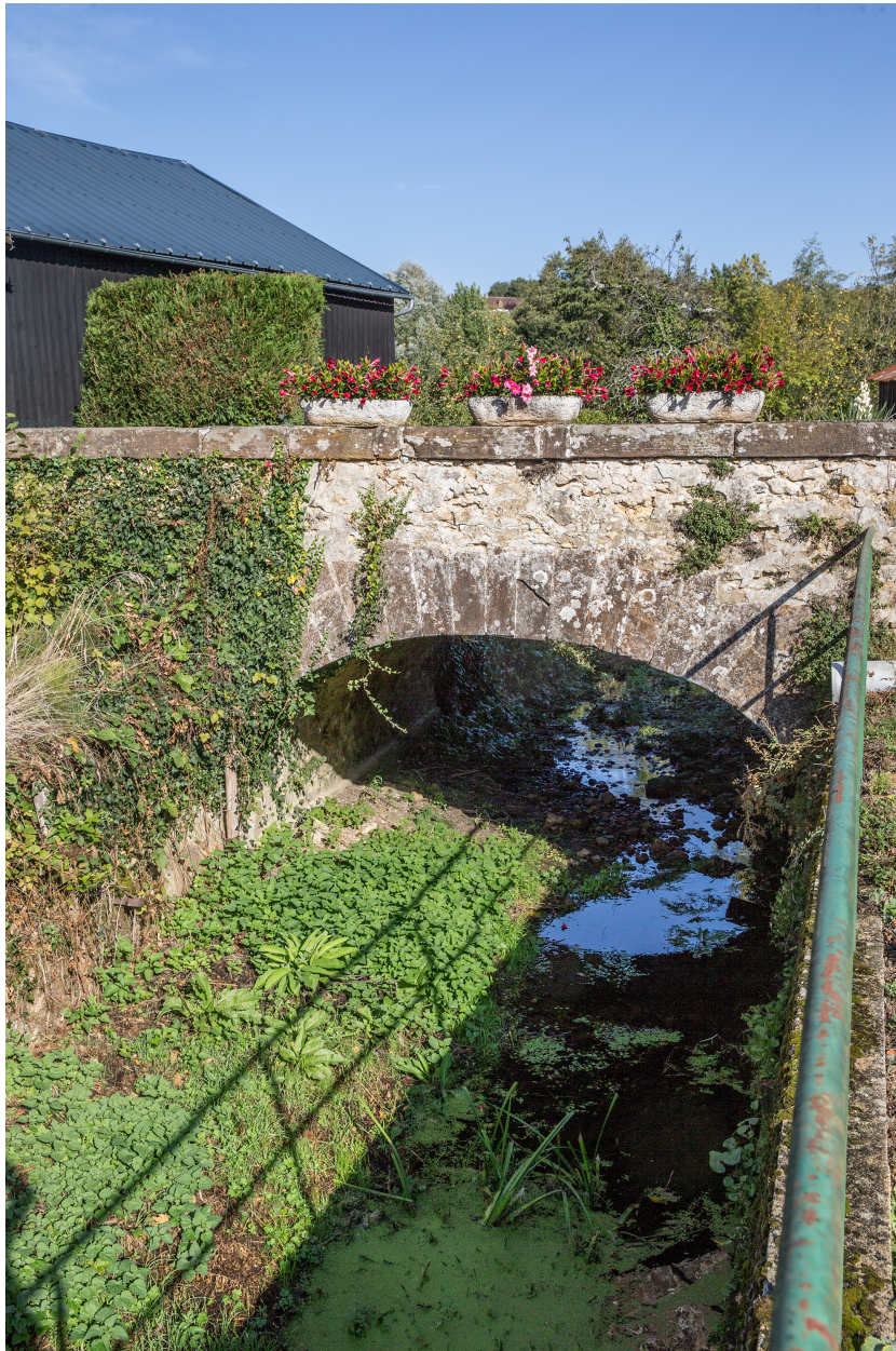
Le pont en pierre sur le Boutry, la rue de l'Industrie.
