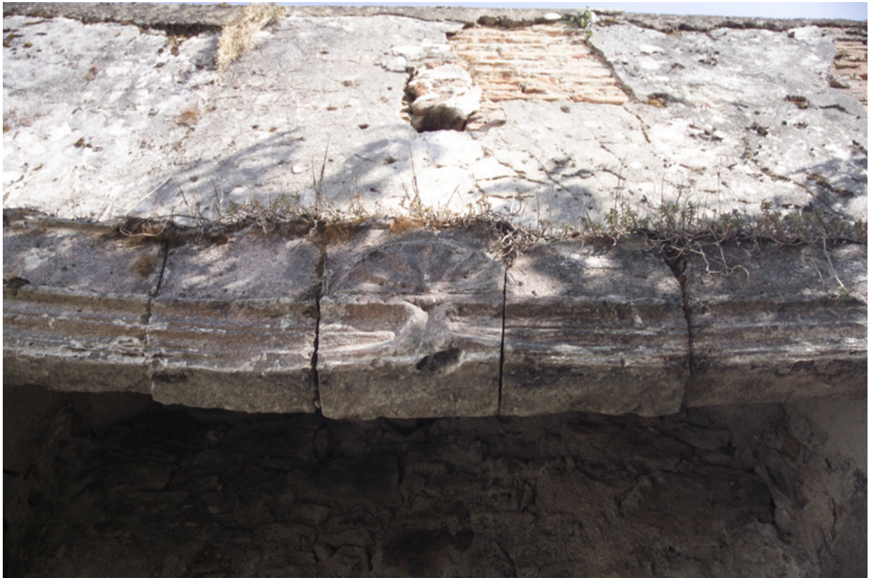
Vestige de la cheminée sur la cour, détail du motif central.
