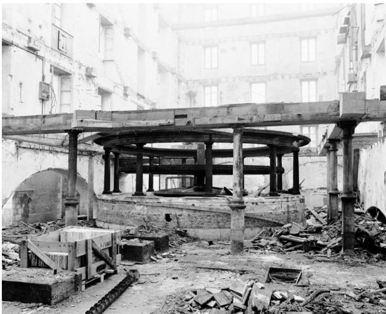
Bâtiment A ; Vue d'ensemble au niveau du rez-de-chaussée depuis l'ouest.
