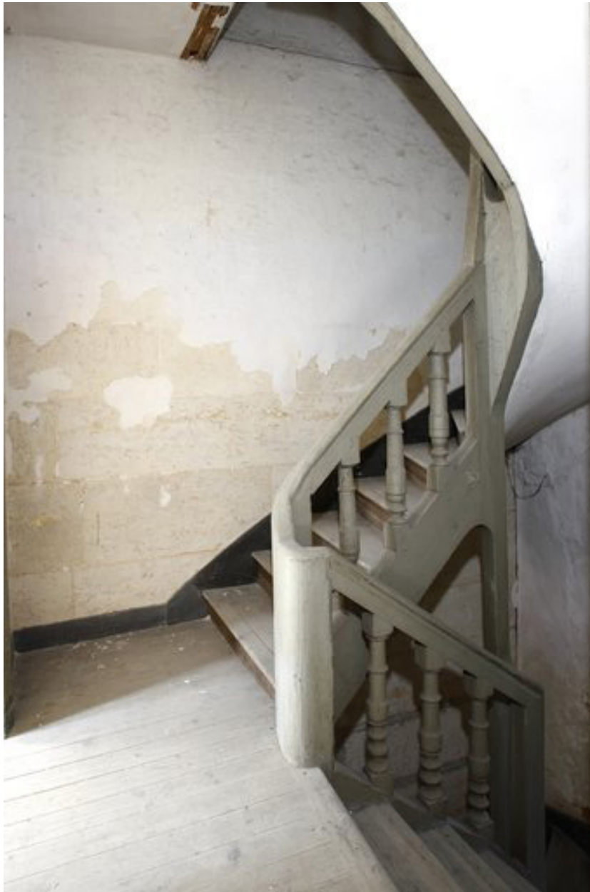
Vue de l'escalier, prise du palier du premier étage.
