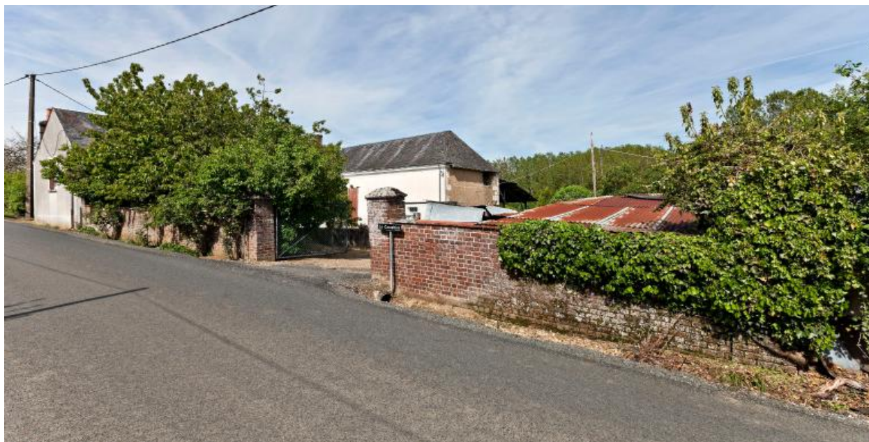
Vue d'ensemble depuis le sud-ouest. Portail charretier en briques.
