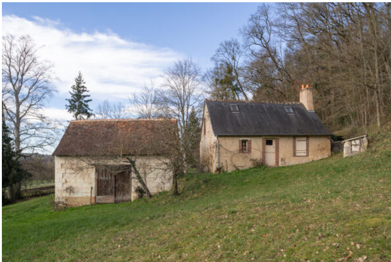
Logement et grange de la Cave Boutin.
