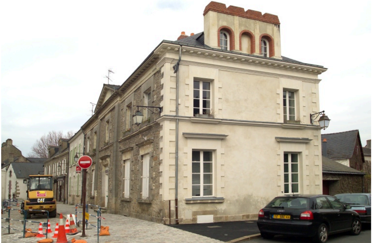
Vue de 3/4 vers le Nord-Ouest.
