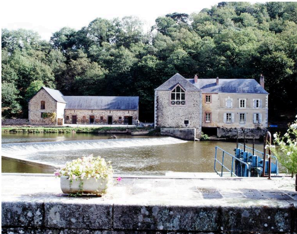
Vue d'ensemble depuis la rive droite : les dépendances (remise, écurie), le moulin, le logement du meunier.
