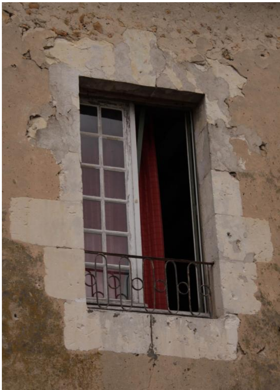
Maison de gauche, étage : fenêtre gauche avec garde-corps en fer forgé.
