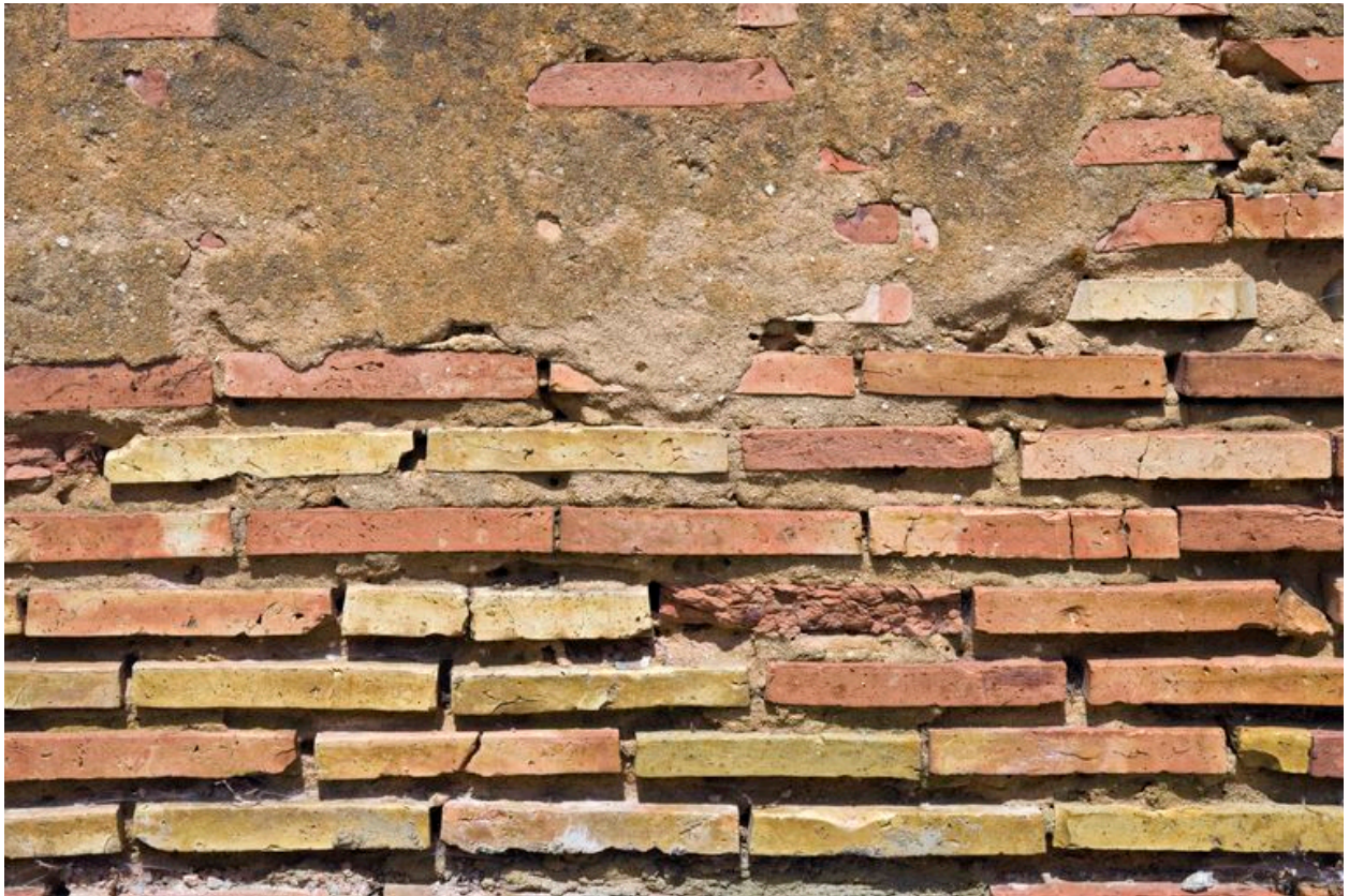
Détail du gros-œuvre de la grange
