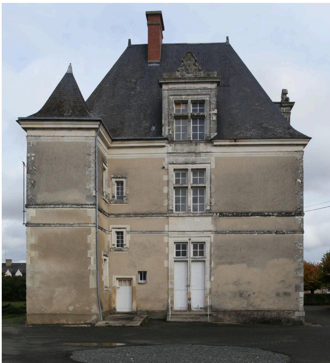
Bâtiment principal : pignon ouest.
