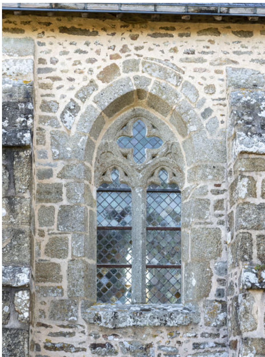
La baie gothique du mur sud de la nef.
