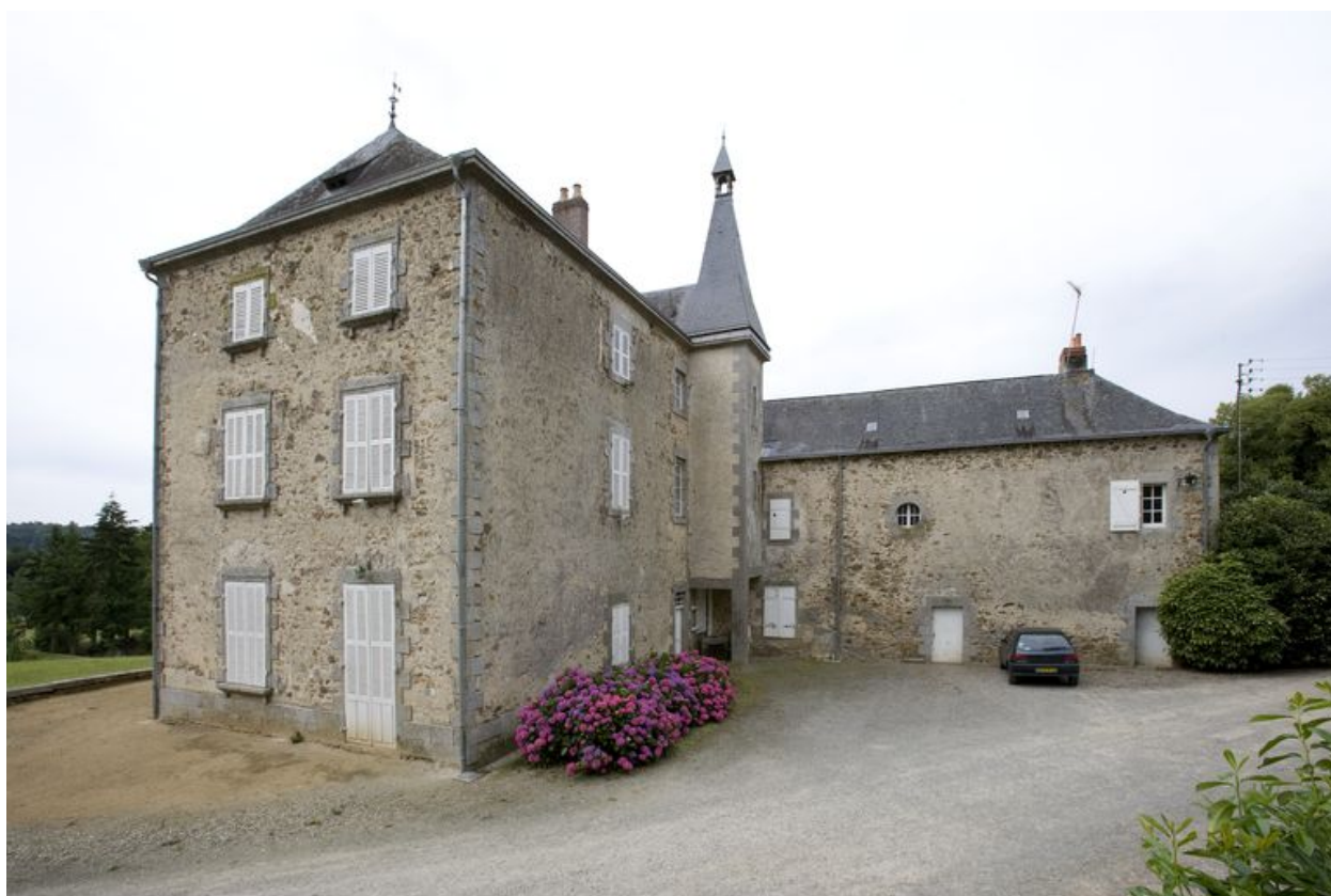
Le château : façades postérieures du corps principal et de l'aile vues depuis le nord-est.
