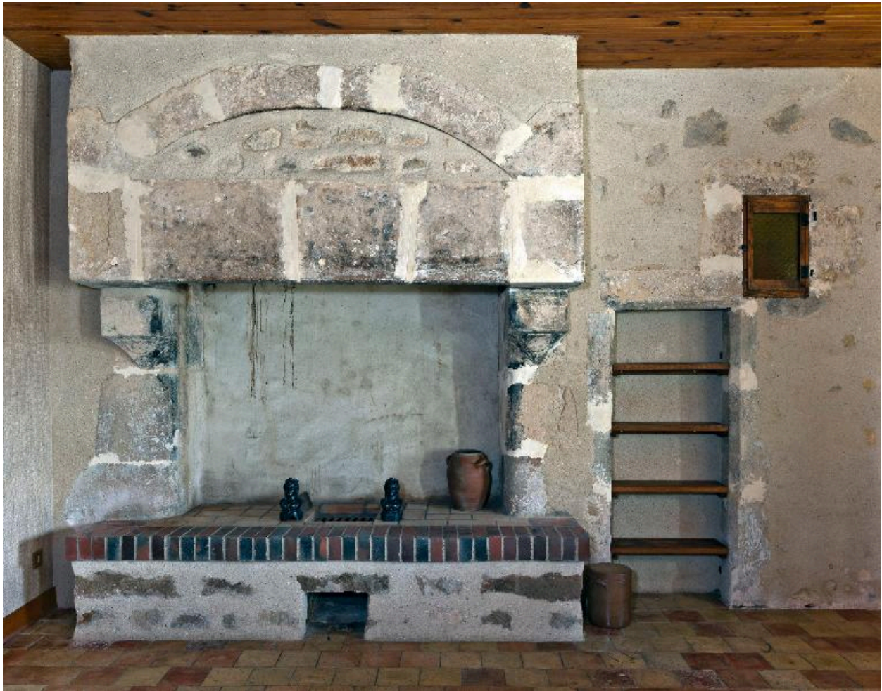
Cheminée du logis, XVIe siècle.
