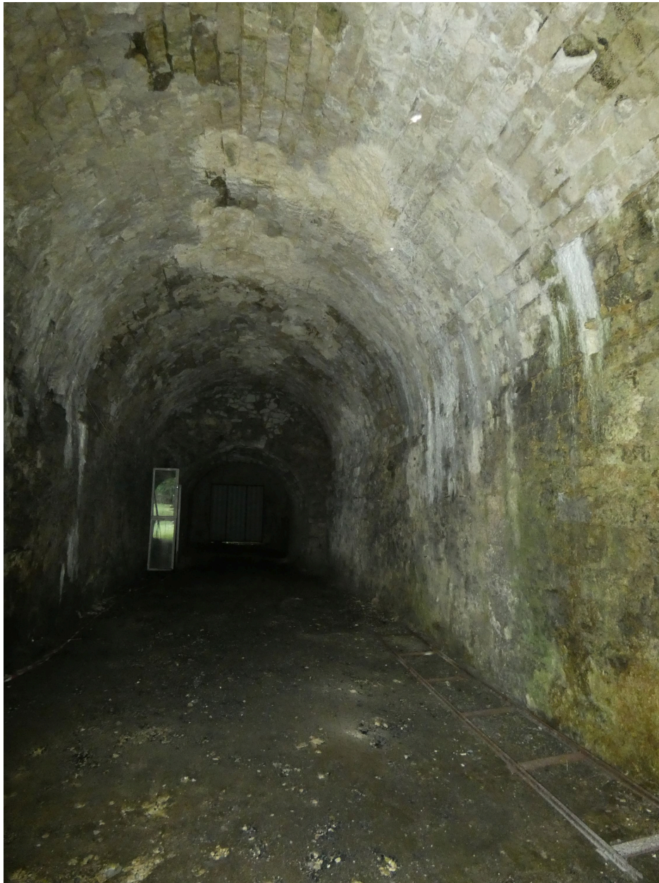
Le tunnel reliant la seconde carrière et le pied des fours.
