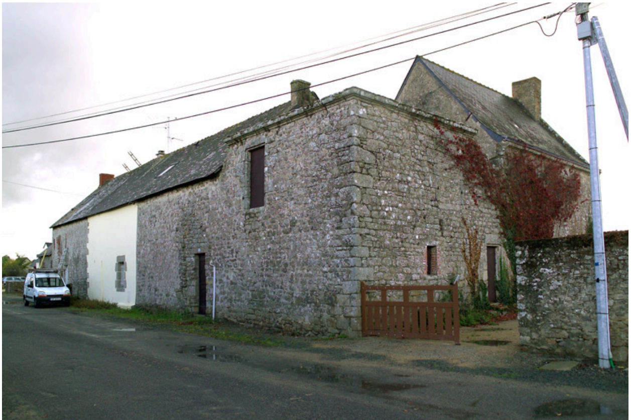
Ensemble depuis le sud-ouest.
