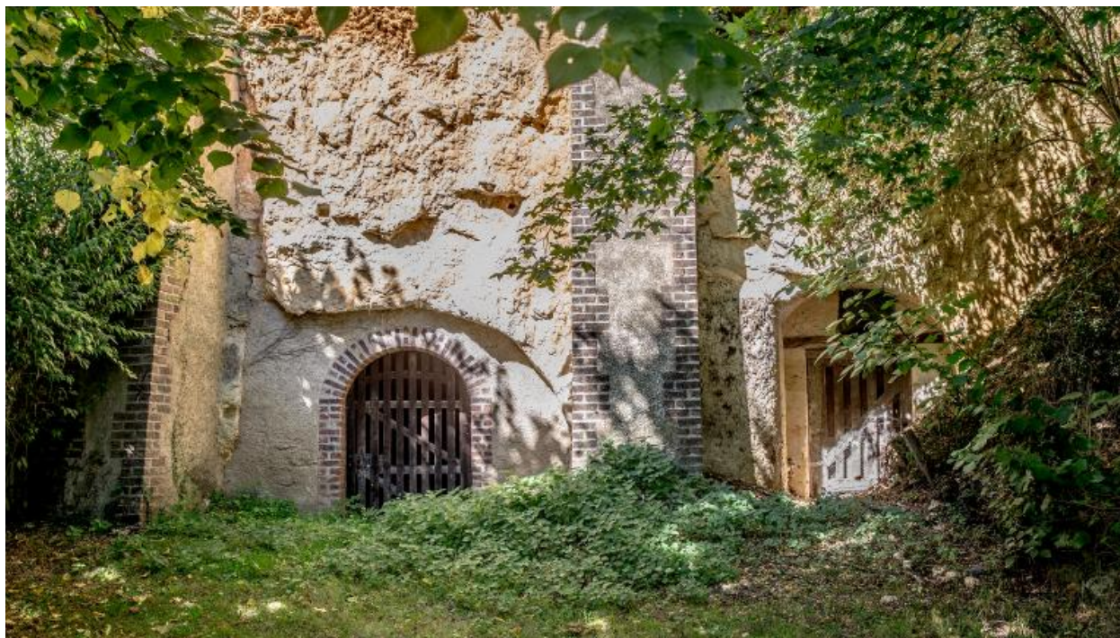
Caves troglodytiques aux Galbrunières.
