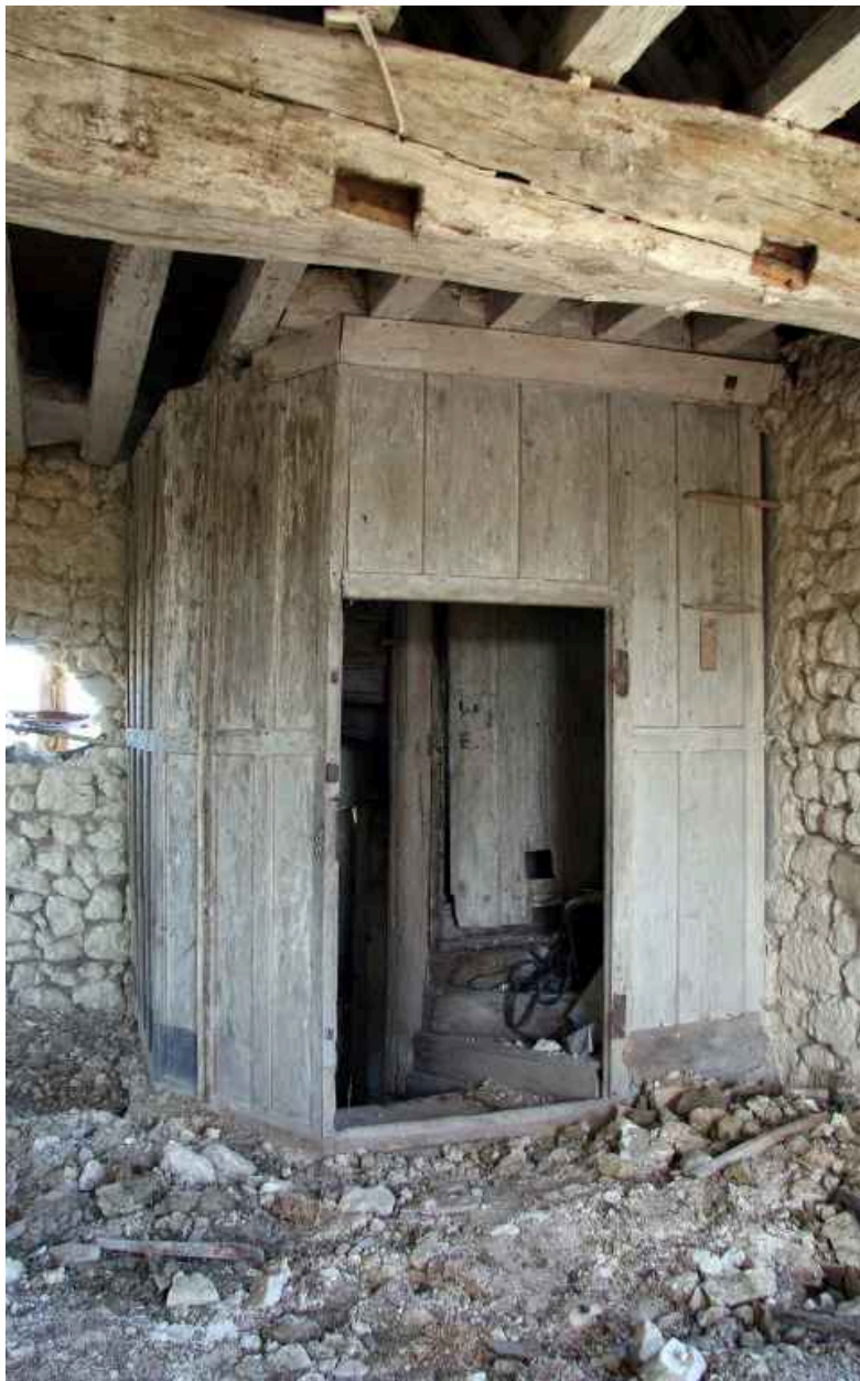
Cage d'escalier à panneaux de bois et vis en bois.
