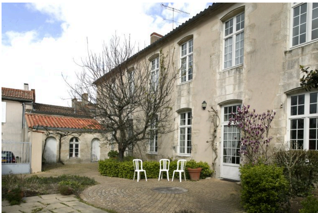
Vue partielle de la façade sur jardin.
