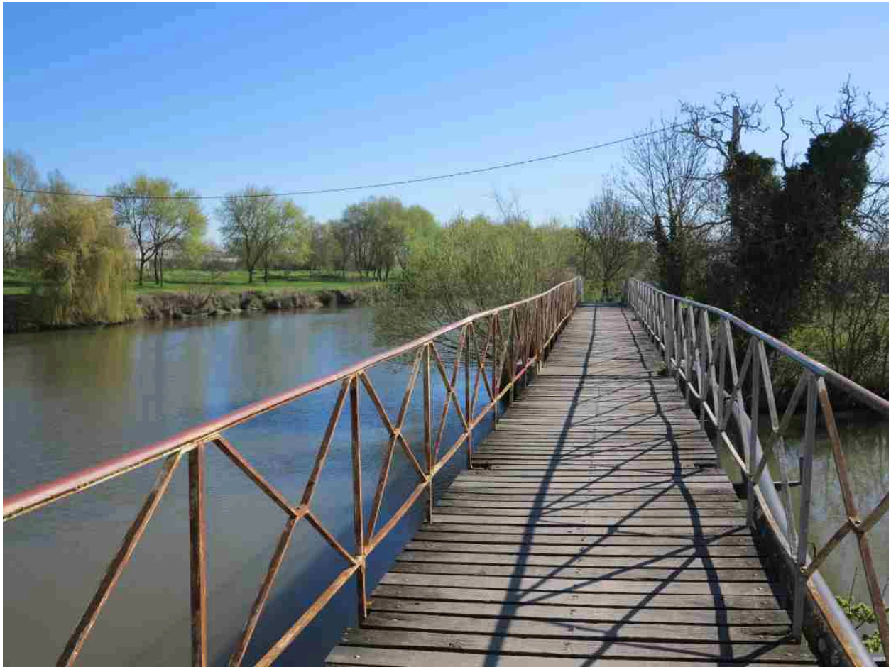
Le dessus de la passerelle vu depuis la rive gauche, à l'ouest.
