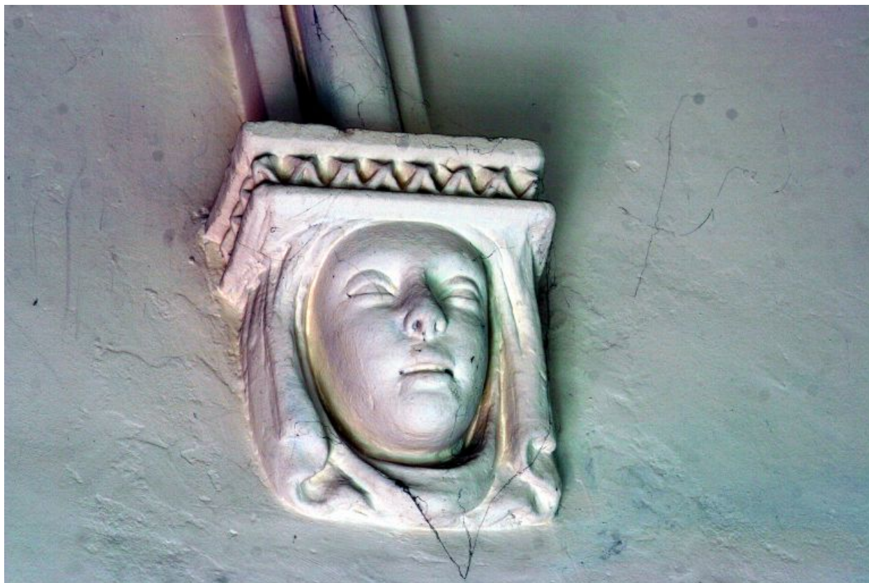
Voûte de l'abside : culot 5.
