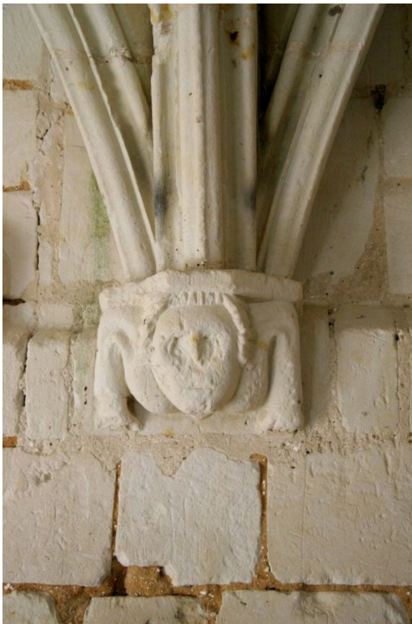
Ancien château, rez-de-chaussée, 1ère salle voûtée : culot figuré (2).
