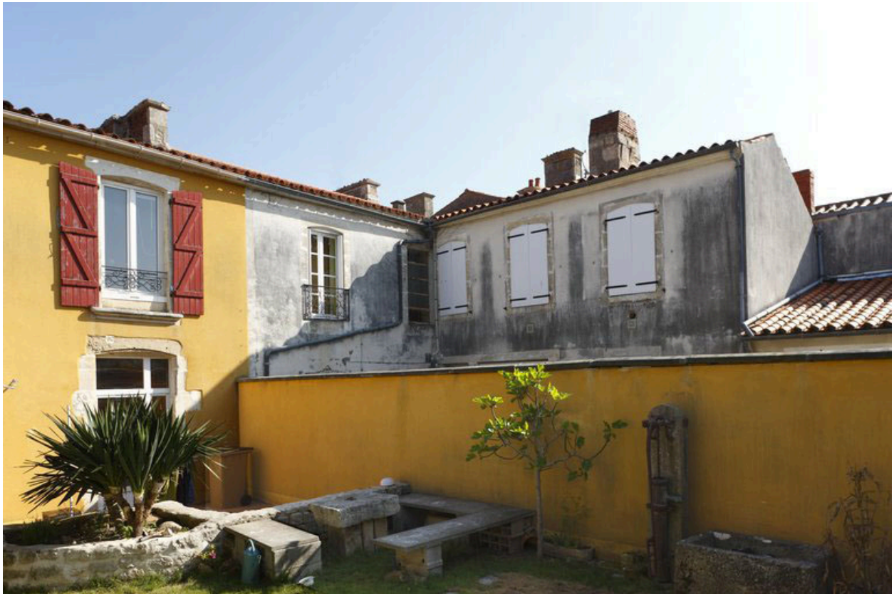
Façades sur cour de la maison (vue prise de la cour du n° 10).
