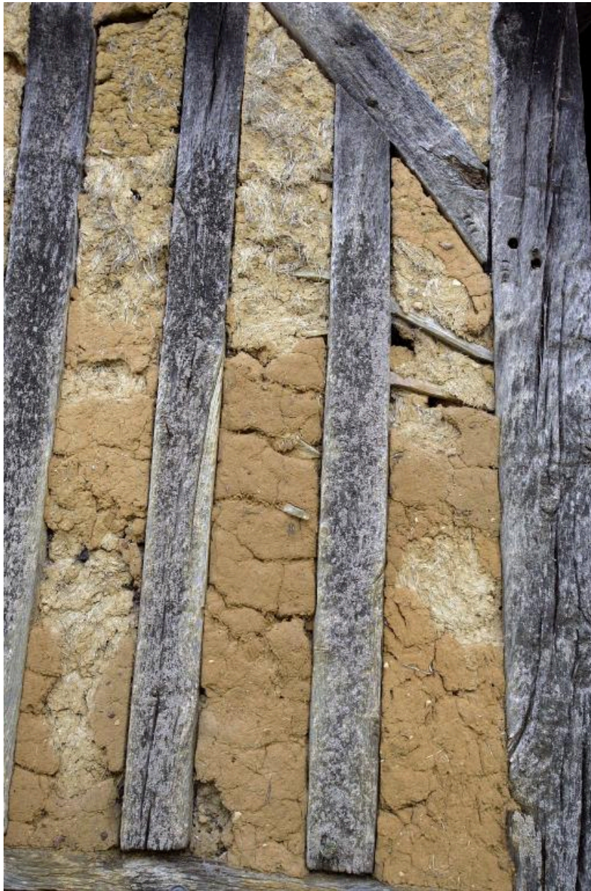
Grange-étables-remise, élévation antérieure : détail.
