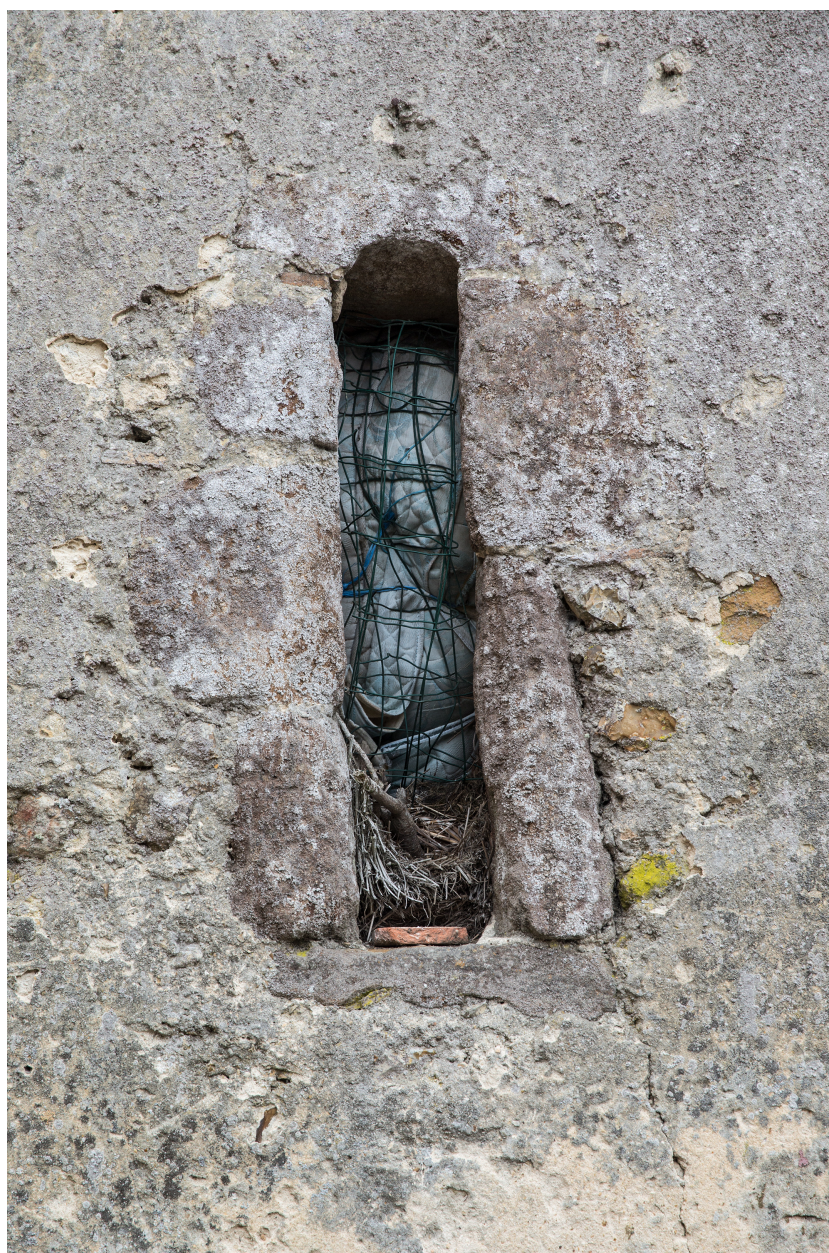
La baie médiévale de la grange.
