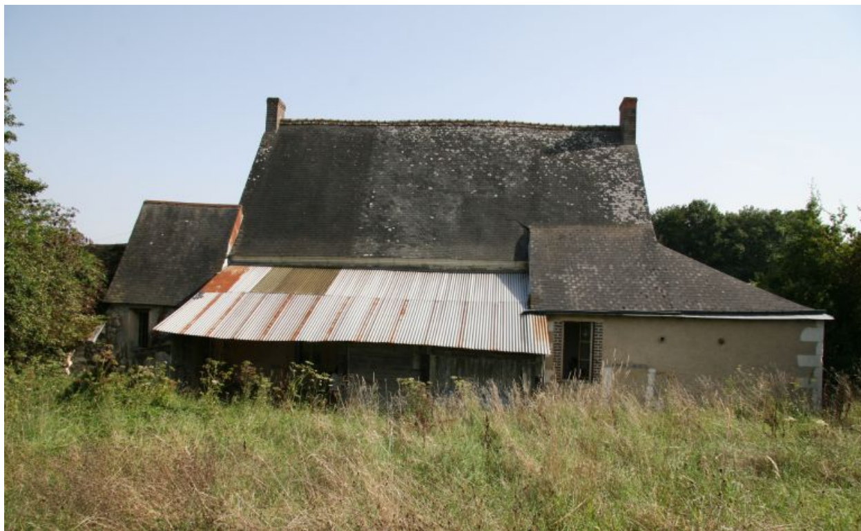
Vue de volume prise du nord.
