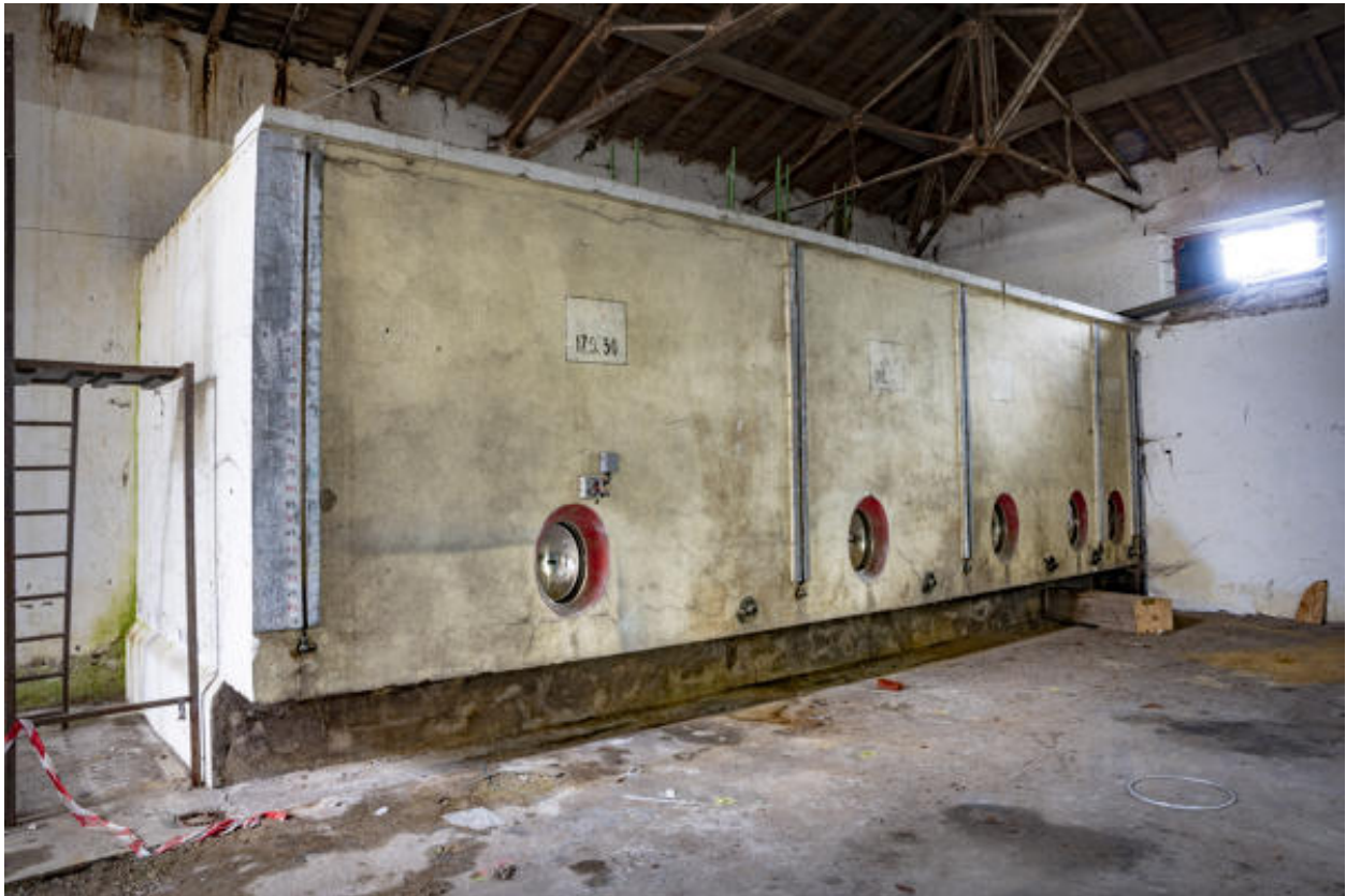
Cuverie principale, vue des cuves en partie nord.
