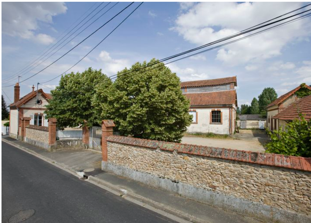
Vue d'ensemble des abattoirs prise du sud.
