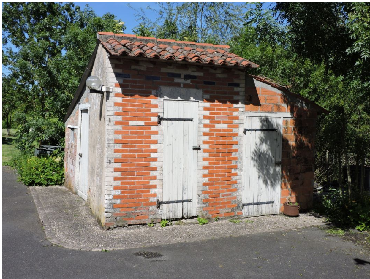
Remise au nord-est de la maison, à l'avant du ruisseau, vue depuis le sud.
