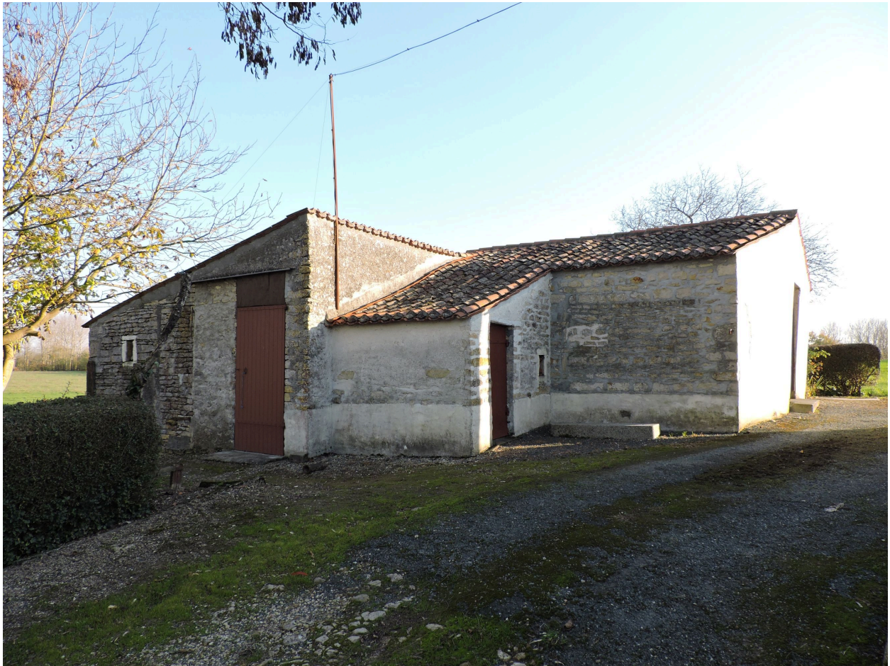
Le fournil à l'est du logis, vu depuis le nord-ouest.
