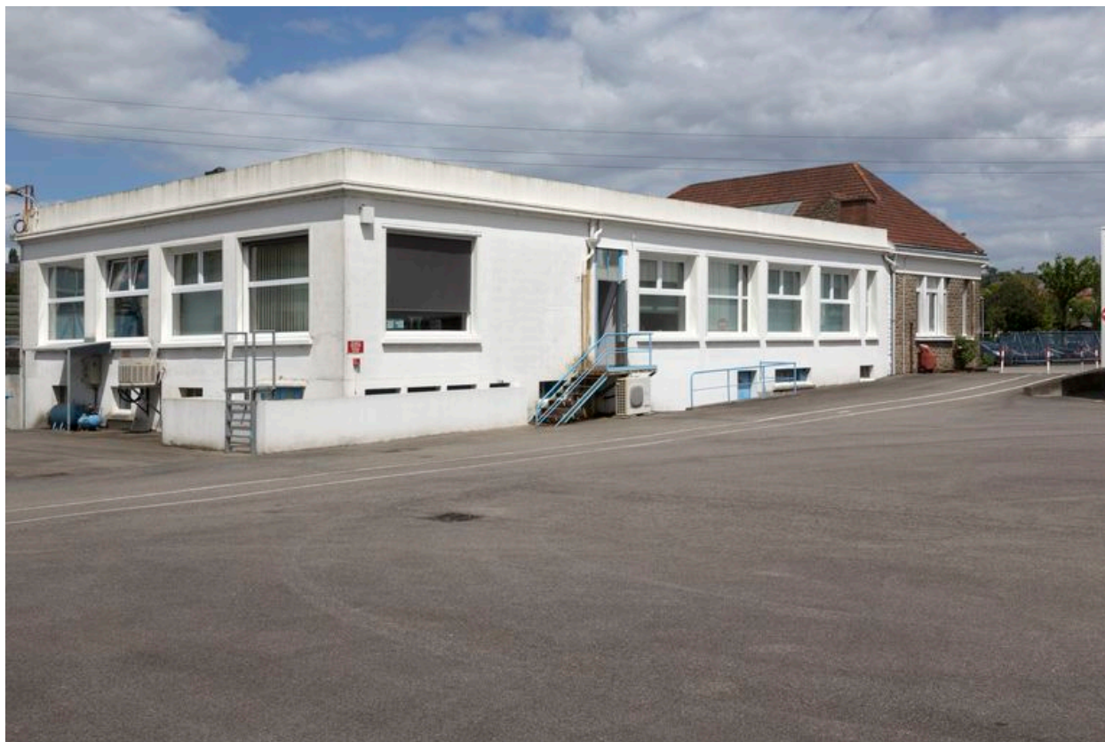
Arrière du bâtiment administratif.
