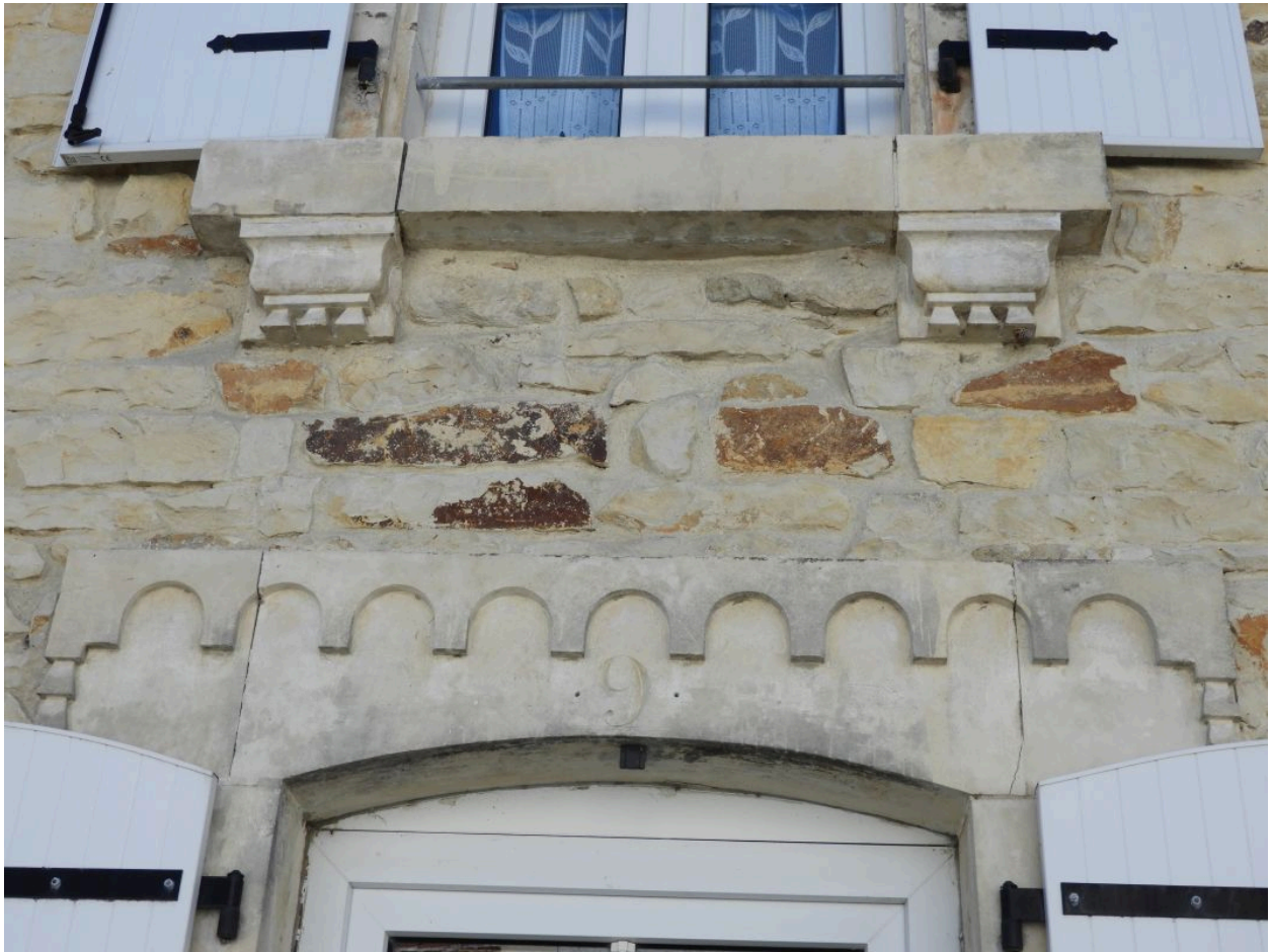
Détail de la façade : appui à modillons, linteau à décor crénelé portant le chiffre 9 (partie de la date 1892).
