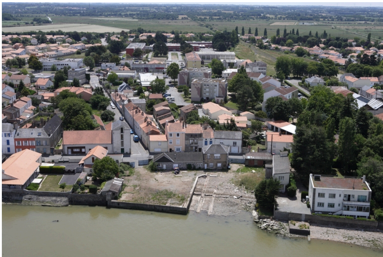
Vue aérienne de la partie aval, 2010.
