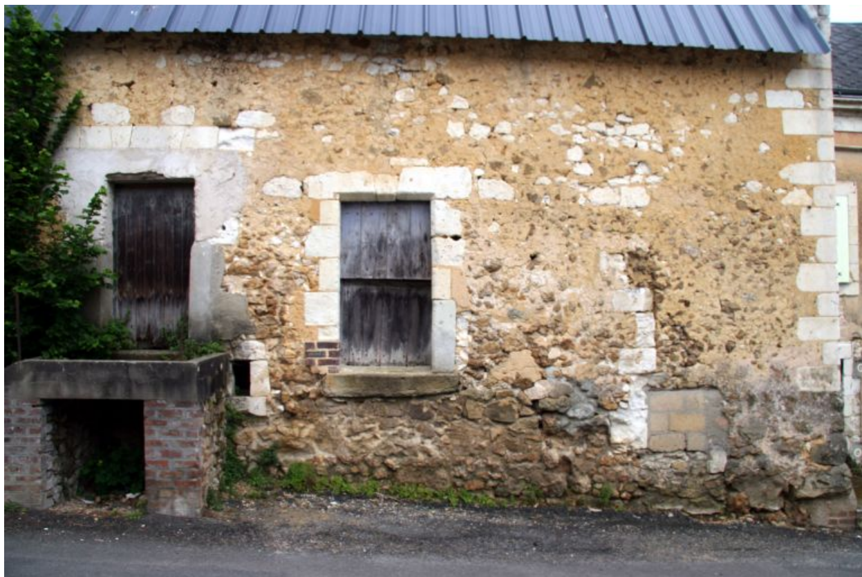
Façade sur la rue des Brouettes.
