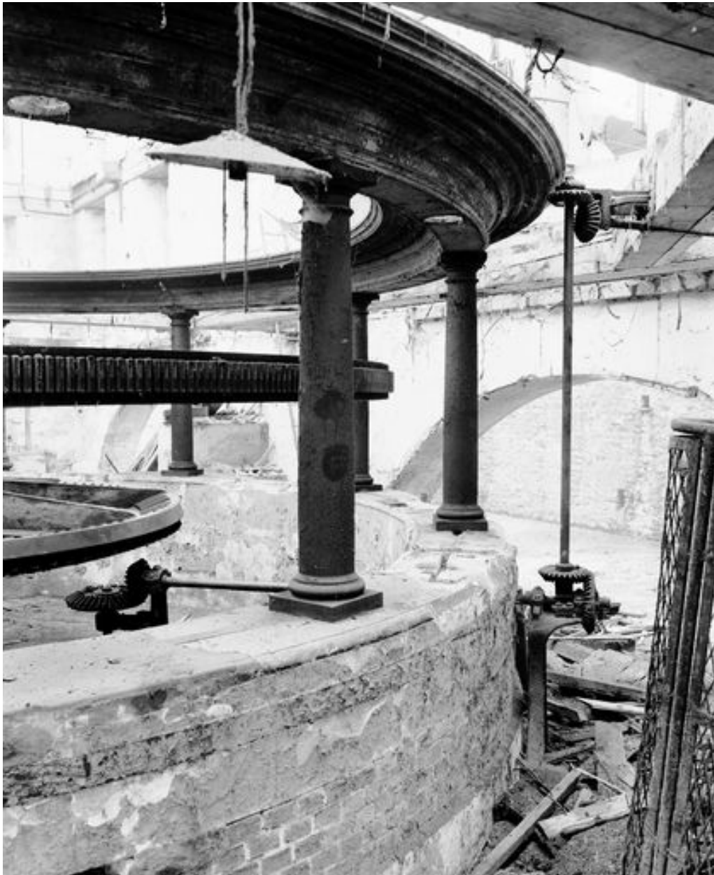
Bâtiment A : détail de la cage.
