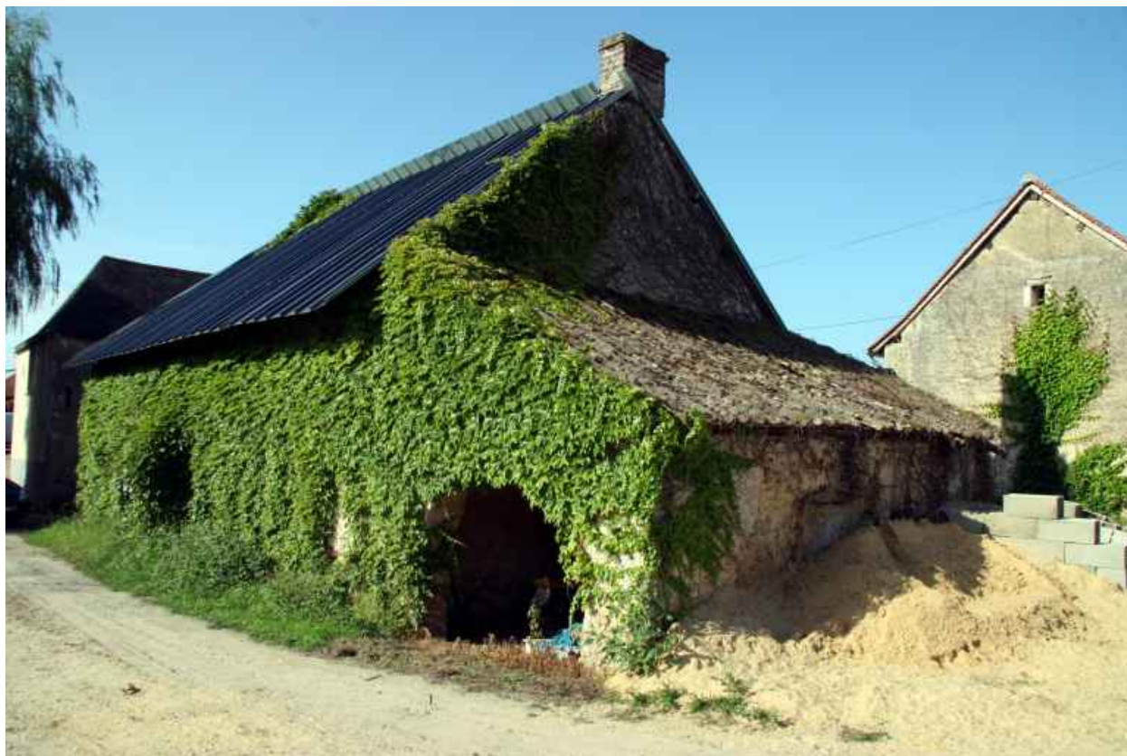
Vue d'ensemble du pignon de la première maison et de la façade postérieure de la deuxième.
