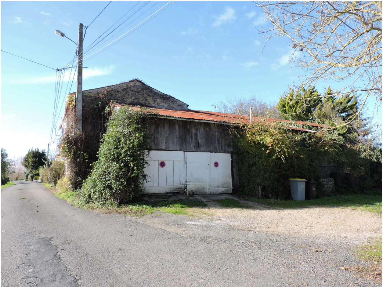
Les dépendances à l'est vues depuis l'est.
