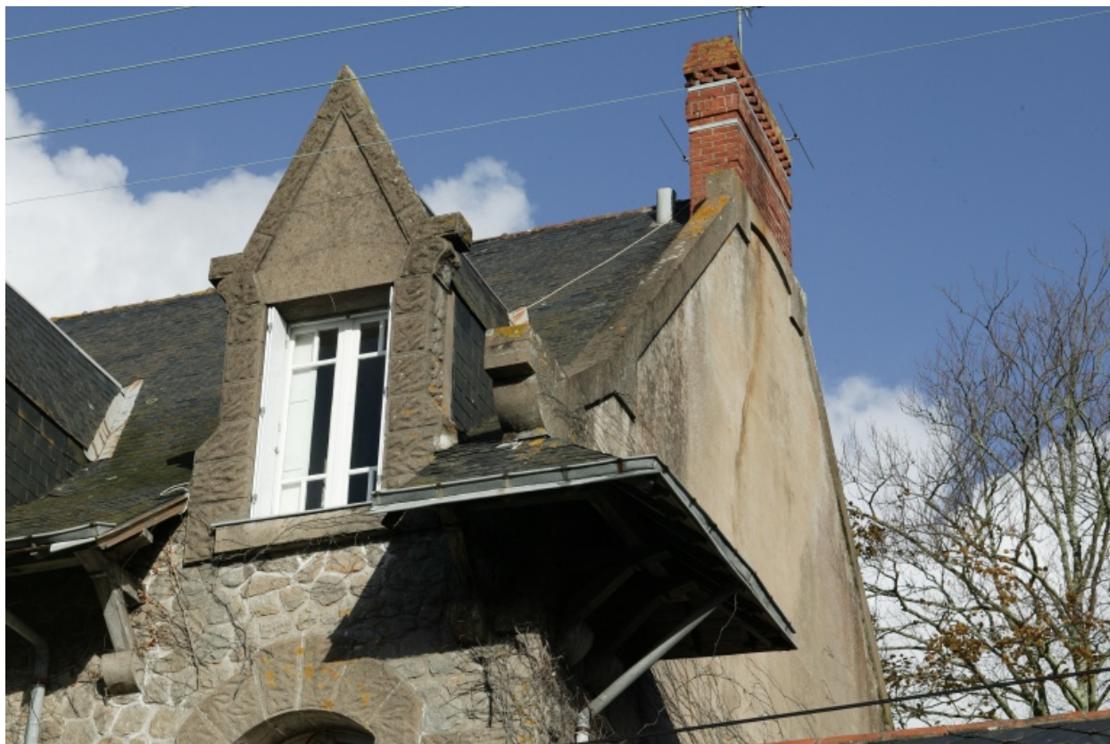
Détail du pignon est.
