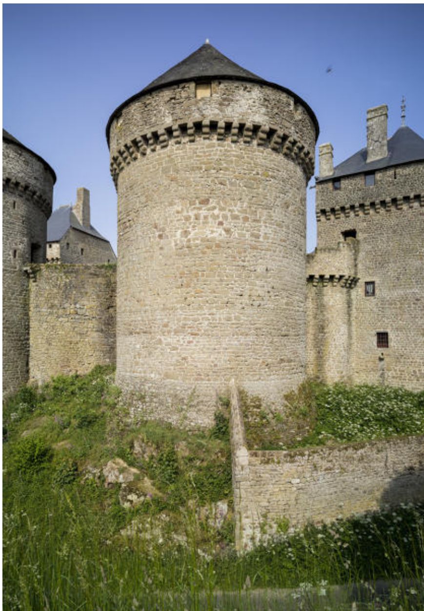
Tour 4, vue depuis la place du boile.
