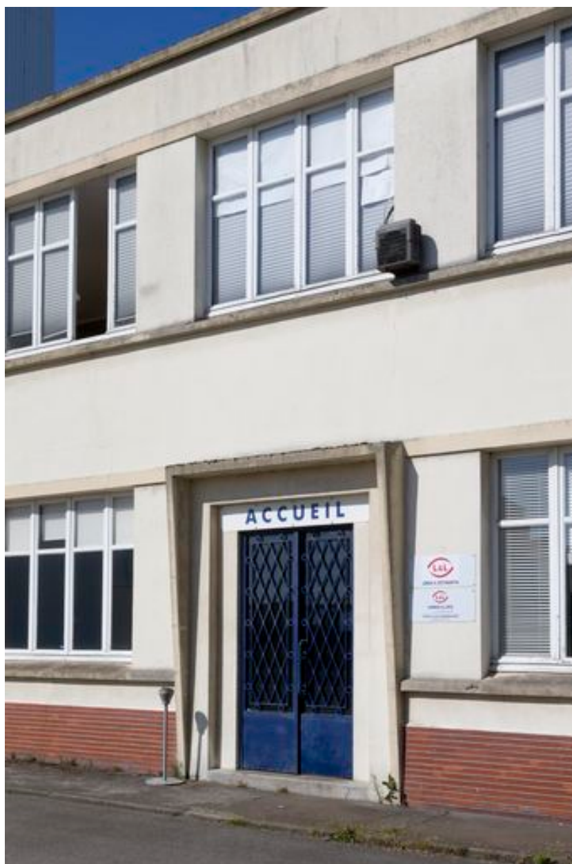
K : détail de la porte d'entrée des bureaux.
