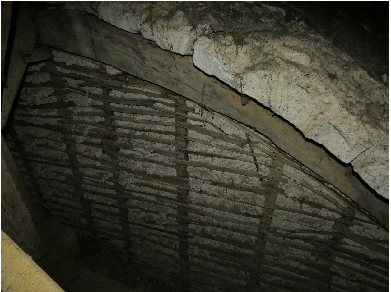
Mur en torchis sous l'arc formeret d'une des voûtes de la nef.
