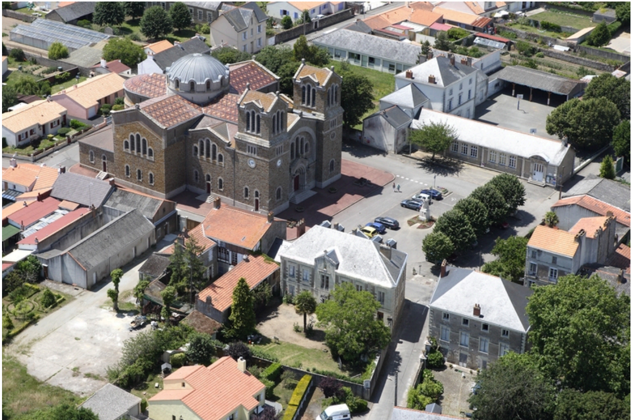
Vue aérienne 2010, vue d'ensemble à l'ouest de l'église.
